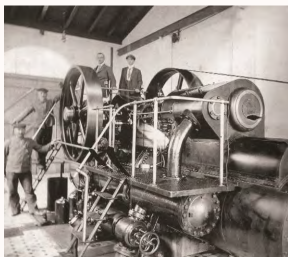
Dampfmachine der Brauerei Schneider (Inbetriebnahme 1910) 52
